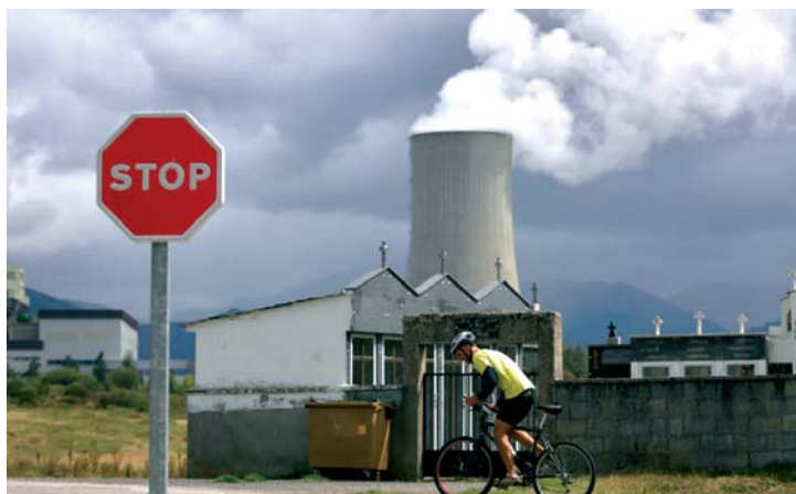
Fig. 5.1.- Central Térmica Anllares, (León).
