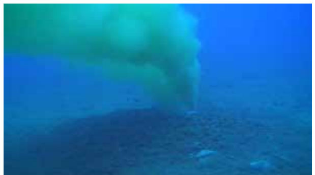
El emisario submarino de Caletillas
