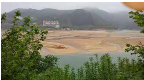
Obras en Laida-Mundaka
