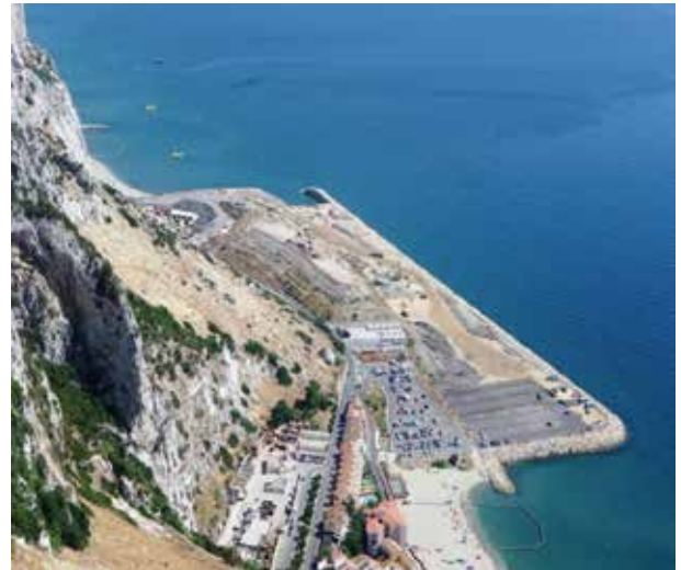
Rellenos en el proyecto East Side de Gibraltar
